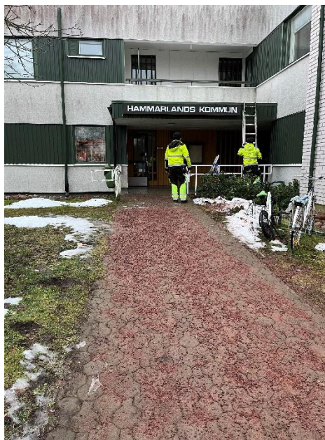
Bild av ramp gjord av gatsten som leder till entrén.
