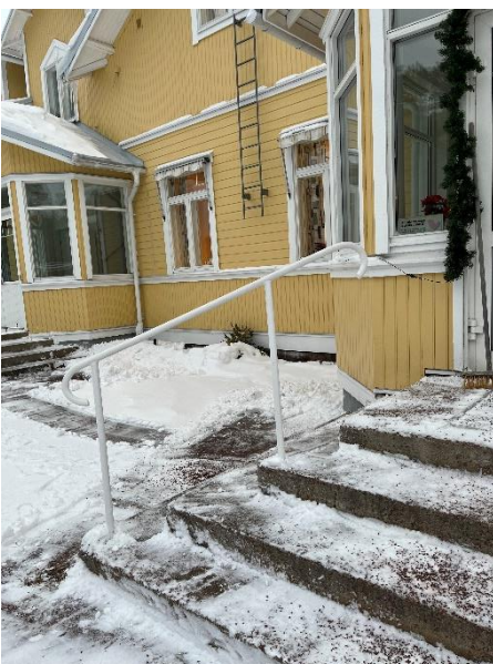
Bild 4 visar ledstång vid yttertrappan.
