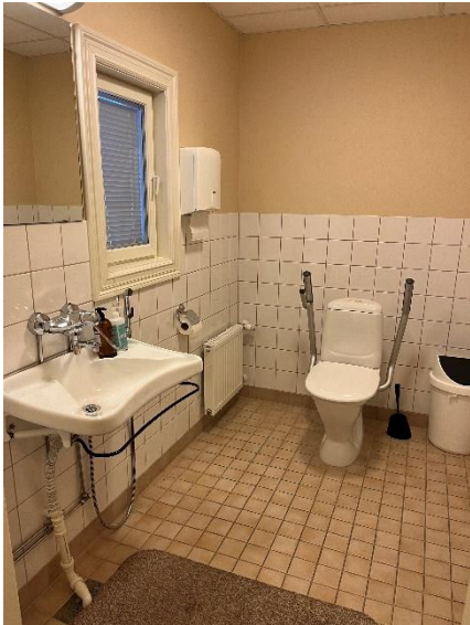
En bild på insidan av toaletten.
