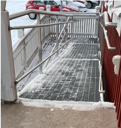
En bild av rampen.
