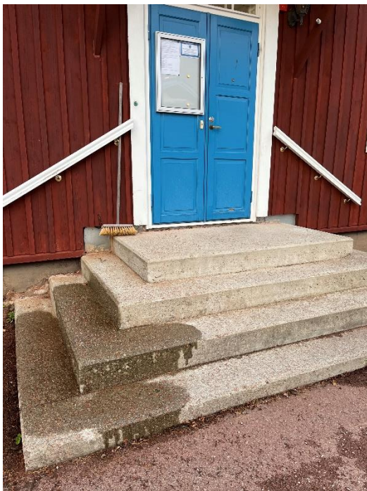
Bild av trapporna som leder upp till huvudingången.
