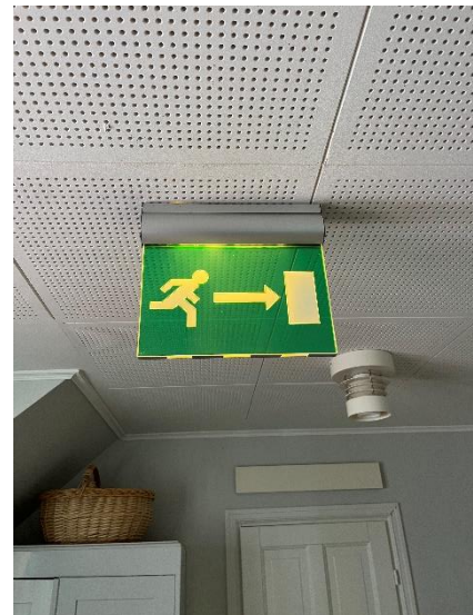
Bild 14 av akustikplattor i taket och utrymningsväg på övre våningen.
