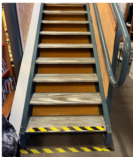
Bild 4. Trappan nära ingången
