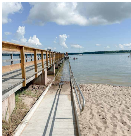
Betongrampen övergår i en träspång som leder till det tillgängliga omklädningsrummet.
