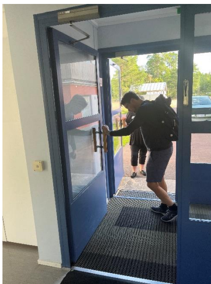
Bild av två personer som krävs för att hålla upp dörrar till gymnastikhallens ingång.
