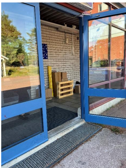
Bild av korridoren vid entrén.
