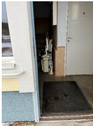
Bild 5 visar en bild av vindfånget vid huvudentrén
