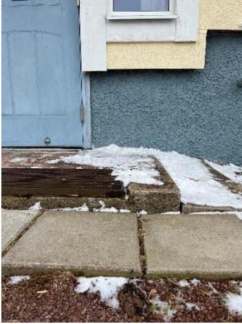
Bild 3 visar en bild av nivåskillnaden vid huvudentrén.
