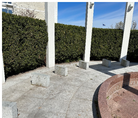
Bild 6. Fundament till träbänken
