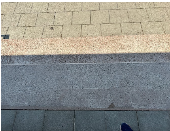
Bild 9. Trappa vid västra entrén.
