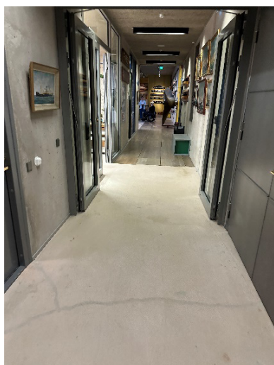
Bild 12. Korridor i källarplan.
