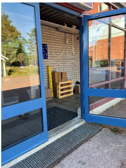
Bild av korridoren vid entrén.
