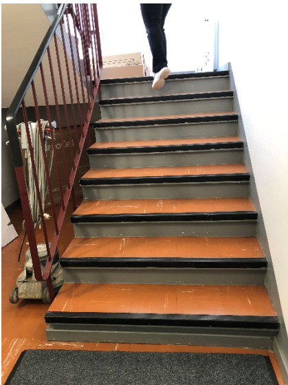
Bild 24: Korta ledstänger.
