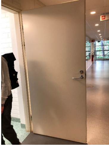
Bild 14: Det saknas draghandtag på insidan av toalettdörren.
