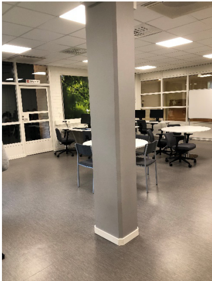
Bild 27: Pelaren bör kontrastmarkeras i två olika höjder.
