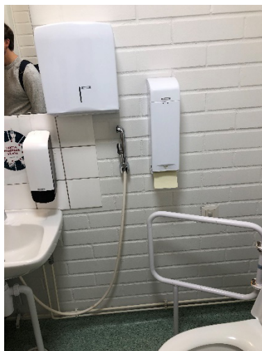
Bild 19: Toalettpappret och bidéduschen bör vara installerad på armstödet.
