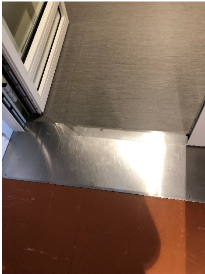
Bild 37: Metallramp i korridoren på andra våningen.
