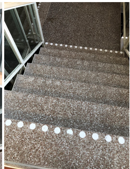
Bild 26: Varje trappsteg bör kontrastmarkeras.
