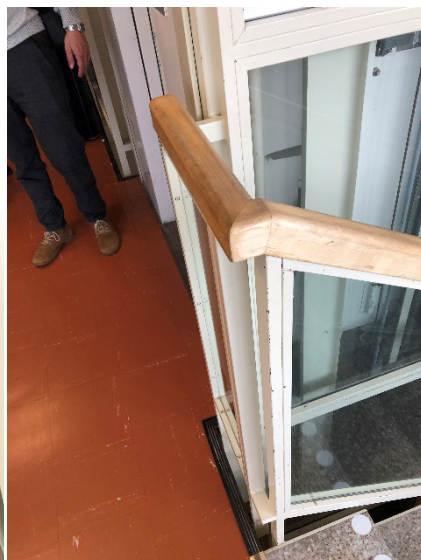
Bild 25: Ledstängerna bör vara längre och avrundade.
