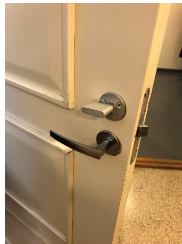
Bild 18: Låset är trög och svårhanterlig.
