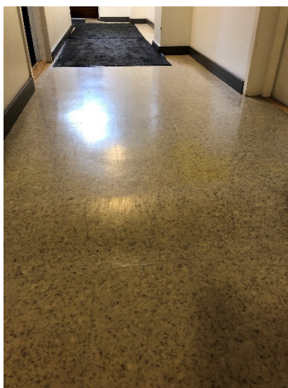
Bild 11: Det finns en märkbar nivåskillnad i korridoren.
