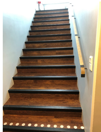
Bild 25: Det finns endast ledstång på ena sidan av trappan.
