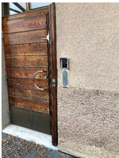
Bild 6: Den automatiska dörröppnaren och kodlåset sitter för högt.
