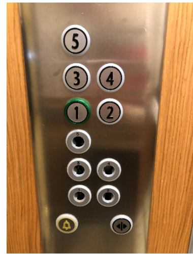
Bild 28: Det finns ihåligheter i kontrollpanelen.
