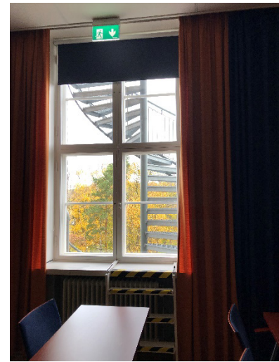
Bild 16: Det finns en utrymningsväg som leder ut genom ett fönster.
