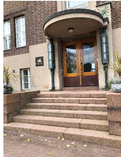
Bild 13: Det saknas ledstänger vid sista trappsatsen.
