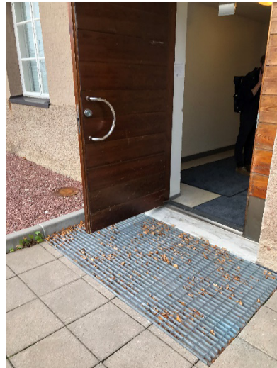
Bild 10: Det finns nivåskillnader vid den tillgängliga entrén.
