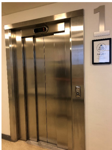
Bild 26: Hissens dörrbredd är acceptabel.
