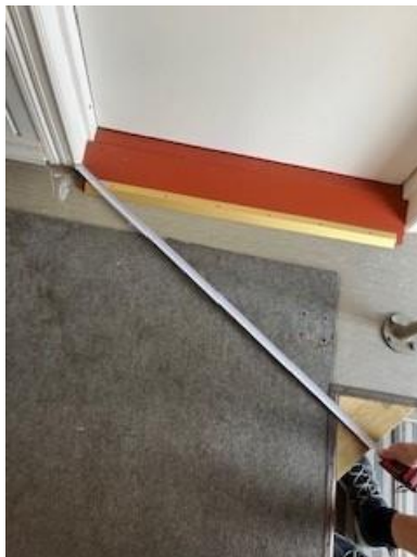
En bild av vindfånget vid rampen.
