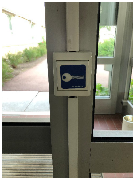
Bild 16: Den automatiska dörröppnaren ser ut som en strömbrytare.
