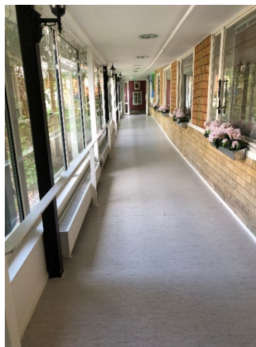
Bild 23: Nedåtgående lutning i en korridor.
