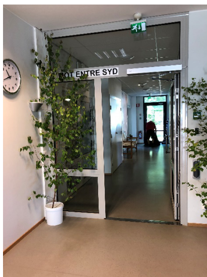
Bild 30: Växtlighet står i vägen för den automatiska dörröppnaren.
