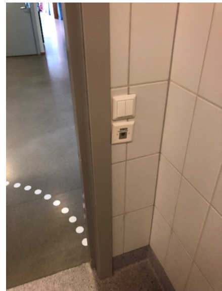
Bild 28: Larmåterställningsknappen är på en lämplig nivå.
