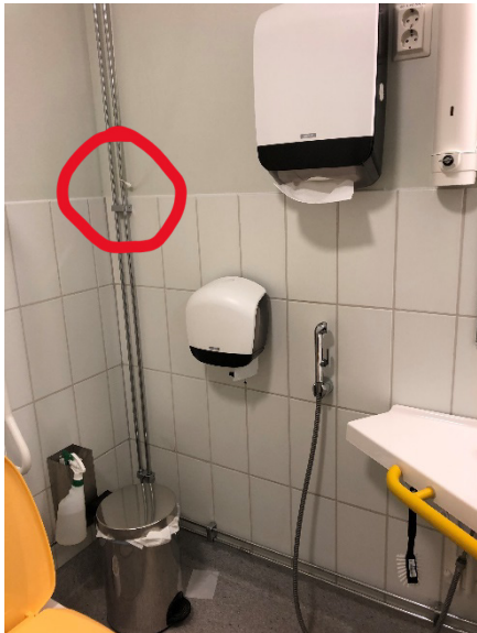
Bild 27: Snöret till larmet bör inte vara knutet på rören då funktionen påverkas.
