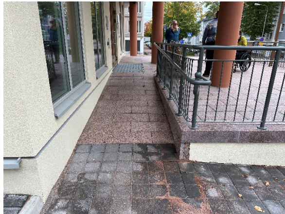
Bild 12. Ramp till entrén.
