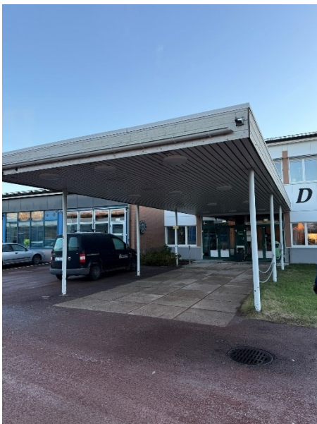
9. D-byggnadens entré med tak.
