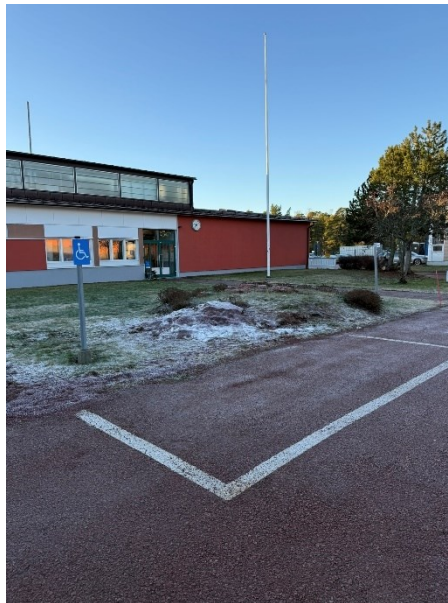
5. Entré till B-byggnaden.
