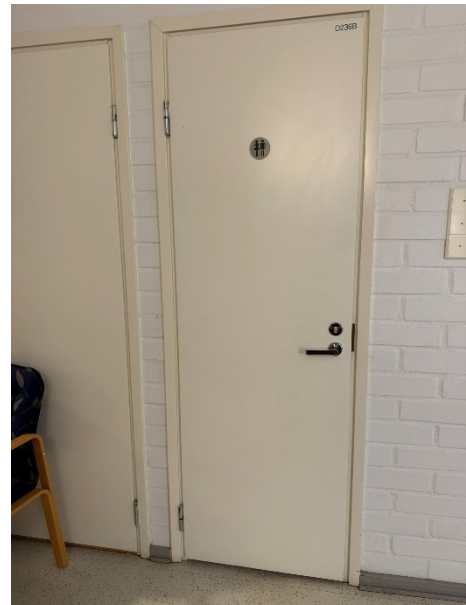
31. Tillgänglig toalett andra våningen i D-byggnaden.
