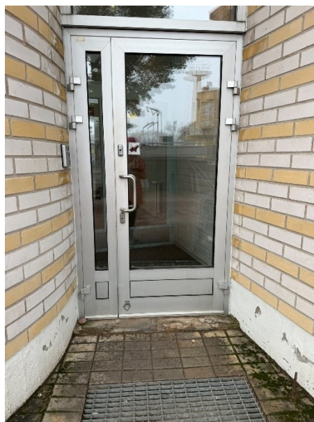
65. Smal entré till maskinverkstaden.
