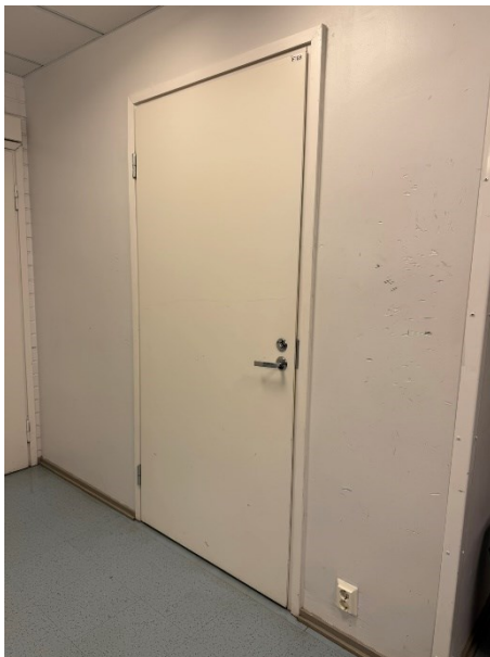
30. F-byggnadens tillgängliga toalett saknar skylt.
