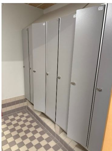
36. Det saknas belysning i skåpen och relief på nummersiffrorna.
