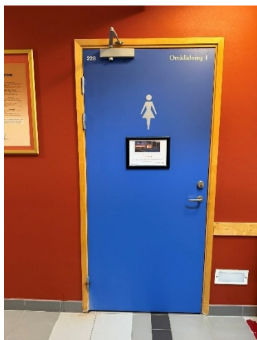
15. Skylten bör vara installerad på väggen.
