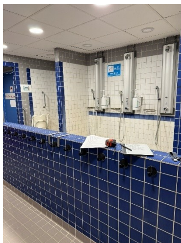
24. De svarta krokarna har för låga kontraster mot den blåa färgen.
