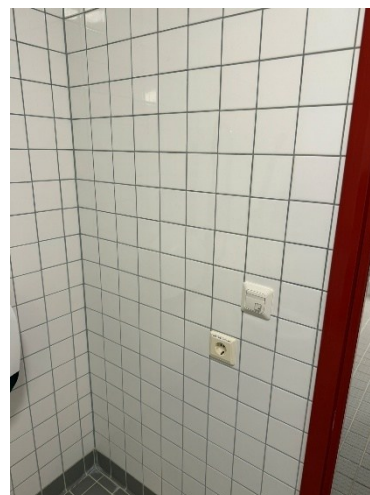
31. Larm och återställningsknapp ska vara lätta att urskilja.
