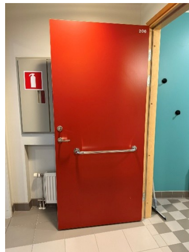
9. Ett vridbart lås kan vara svår att hantera.
