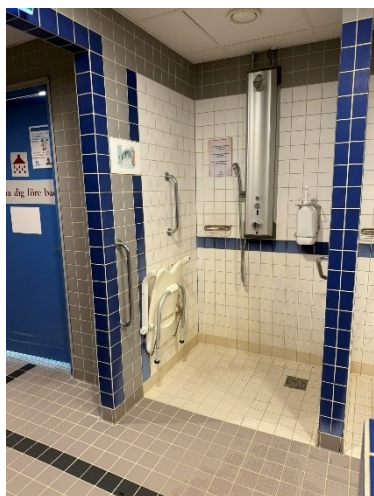
23. Det finns inte nog med vändutrymme i duschen.
