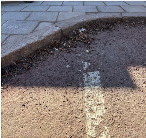
Bild 13. Hög kant vid parkeringsruta.
