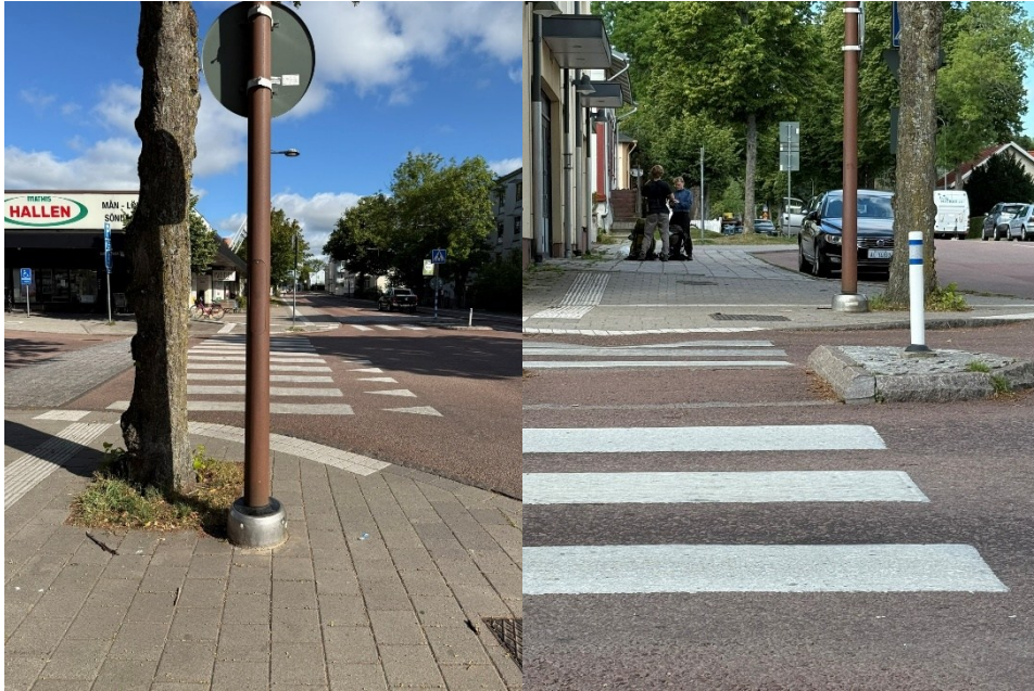
Bild 10: Hinder utgör kollisionsrisk på Ålandsvägen. Bild 11: Marken lutar åt olika håll före övergångsstället.
