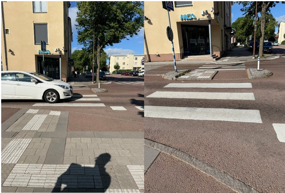
Bild 12: De taktila ledstråken är förvirrande. Bild 13: Refugen är inte tillräckligt bred.
