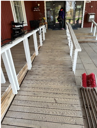
3. Rampen står under ett skyddande entrétak.
