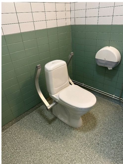
33. Armstöden är installerade direkt i toalettstolen.
