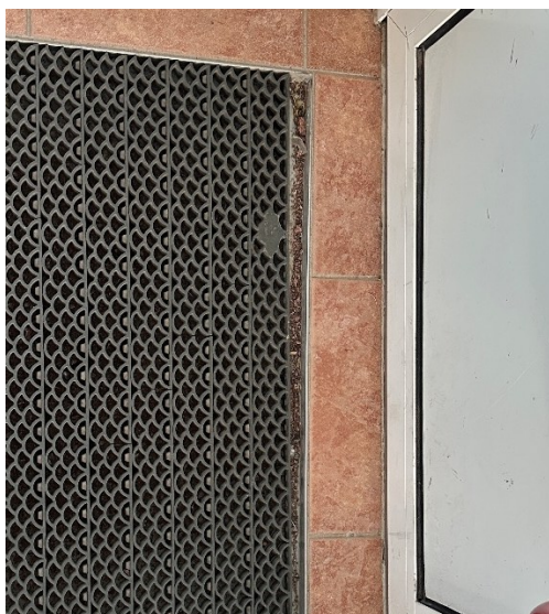
6. Det finns glipor mellan mattan och nedsjunkningen.
