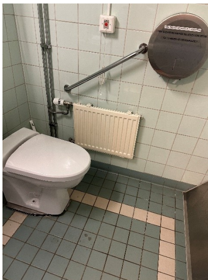
10. Vändytan i den tillgängliga toaletten uppnår en radie på 100 centimeter.
