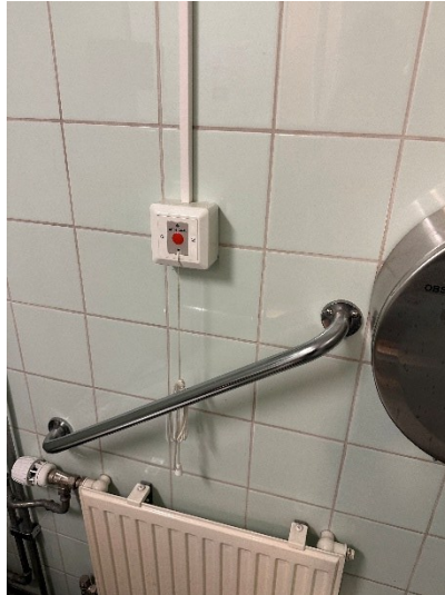
14. Larmet är inte korrekt utformat och snöret är uppvikt.
