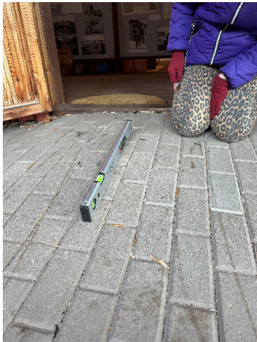
Bild 5. Närbild på ramp till entrén.
