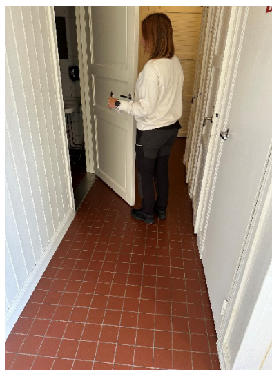
Bild 17. Passage utanför toaletter
