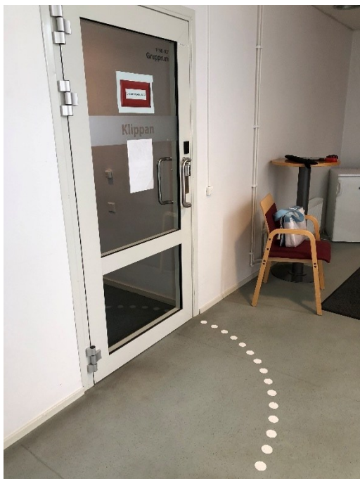
Bild 8: Dörrens slagyta är markerad på golvet.
