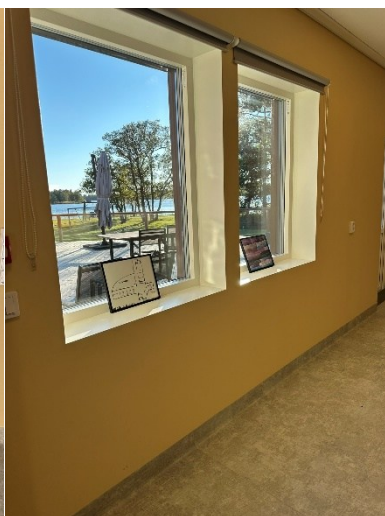
Bild 9: Fönster på lägre nivå.
