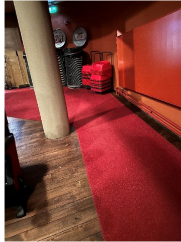
Bild 11. Gången i salongen sluttar uppåt, ledstång saknas.
