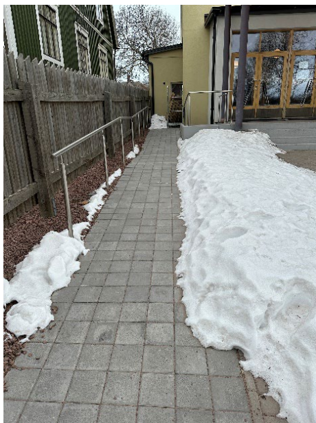
Bild 3. Vägen till den nya rampen.
