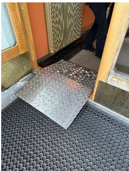
Bild 6. Plåtramp sätts över tröskeln.
