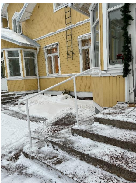
Bild 4 visar ledstång vid yttertrappan.
