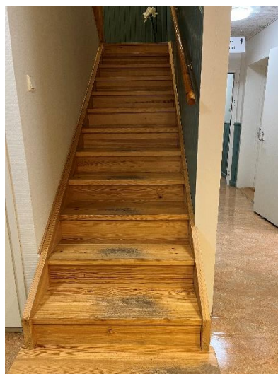
Bild 10 av trappan inomhus.
