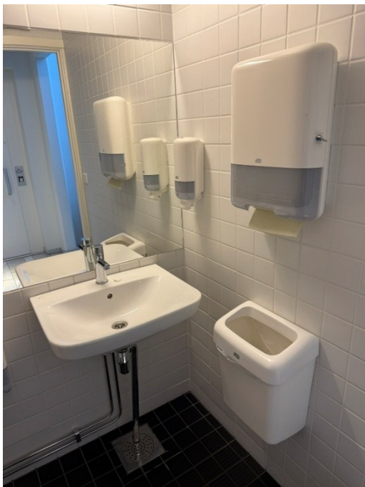
Bild 15 Handfatet är inte justerbart och det saknas kontrastmarkering på den bakre väggen.
