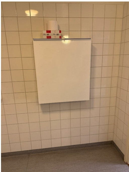
Bild 19 Det finns ett vägghängt skötbord i den tillgängliga toaletten som är placerad på en hög höjd.
