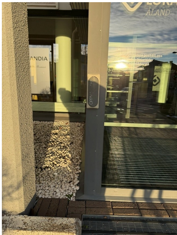
Bild 7 På den automatiska dörröppnaren med en kontrasterande ram runt knappen.
