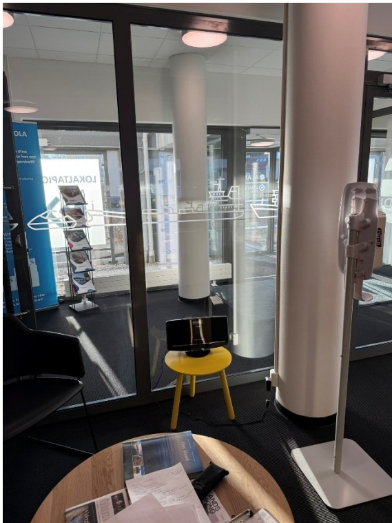
Bild 9 Visar väntrummet och omarkerade glasytor.
