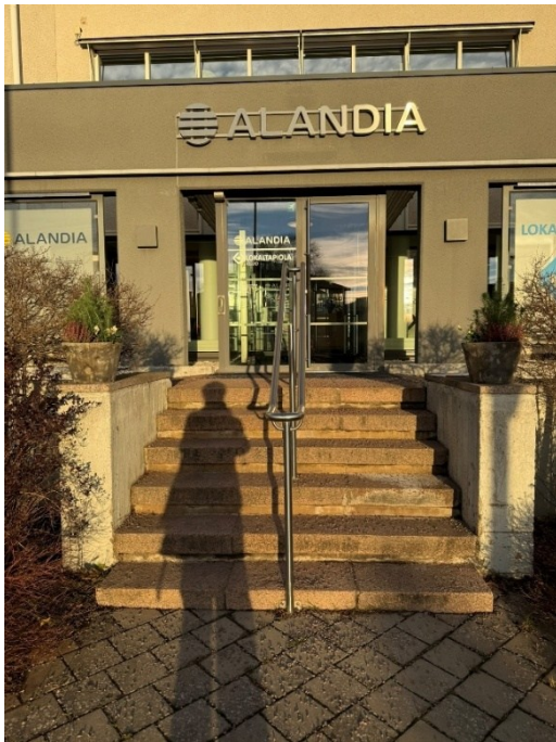
Bild 4 Det finns en ledstång på en höjd i mitten av trappan och trappstegen saknar kontrastmarkering.
