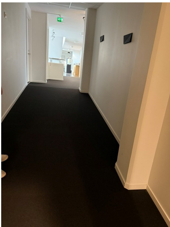
Bild 10 En flackare lutning är alltid att föredra på en ramp även om den är inomhus.
