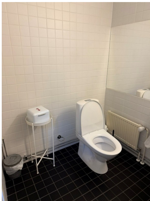
Bild 14 Det saknas kontrastmarkering av toaletsitsen och det finns lösa föremål i vägen inför en överföring.
