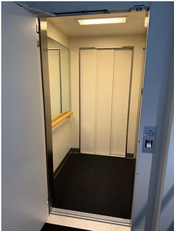
Bild 11 Insidan av hissen har goda kontraster mellan det svarta golvet och de vita väggarna.
