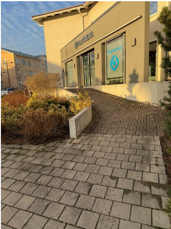
Bild 2 Visar den ena rampen som leder upp till entrén. Den andra rampen är utformad på samma sätt.
