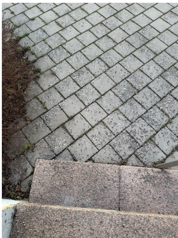
Bild 6 Visar underhållet gångstråk bestående av markplattor där det inte uppstår nivåskillnader.
