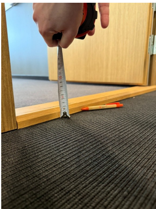
Bild 20 Den totala höjdskillnaden på trösklarna är 3 centimeter men det har gjorts en liten avfasning på 1 centimeter.
