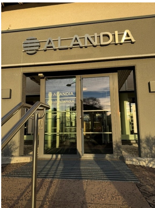
Bild 5 Vit text på glastrutor kontrasterar inte tillräckligt väl.
