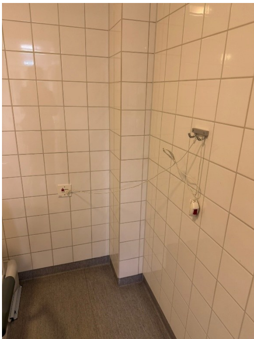
Bild 18 Larmknappen fyller inte sin funktion om snöret är upphängt och den är utmanande att nå.
