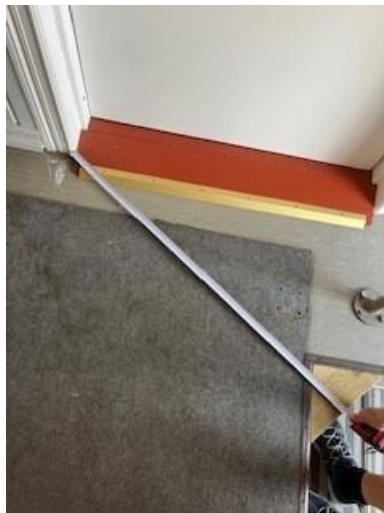
En bild av vindfånget vid rampen.
