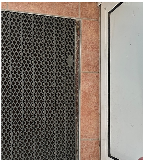
6. Det finns glipor mellan mattan och nedsjunkningen.
