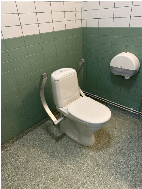
33. Armstöden är installerade direkt i toalettstolen.
