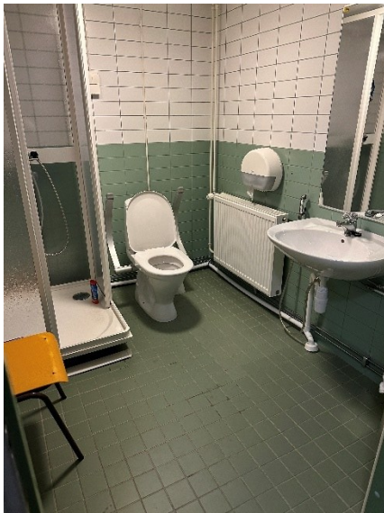
20. Det finns för lite utrymme på båda sidor om toaletten.
