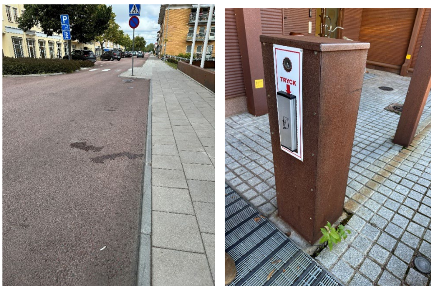
Bild 1. Till vänster: Den långsgående parkeringen direkt utanför entrén med en hög kant. Till höger: Pelare utanför entrén med knapp till dörröppnaren.
