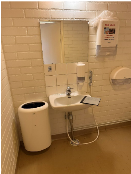
71. Spegeln är installerad på hög höjd.
