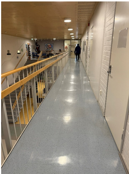
21. Ledstänger i korridoren på andra våningen.
