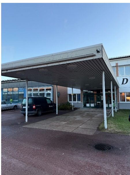
9. D-byggnadens entré med tak.
