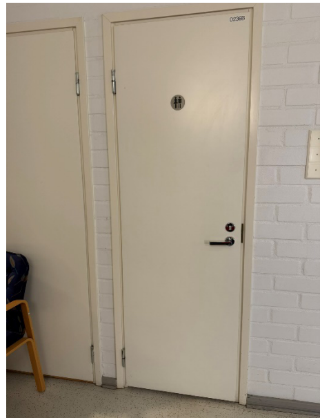
31. Tillgänglig toalett andra våningen i D-byggnaden.
