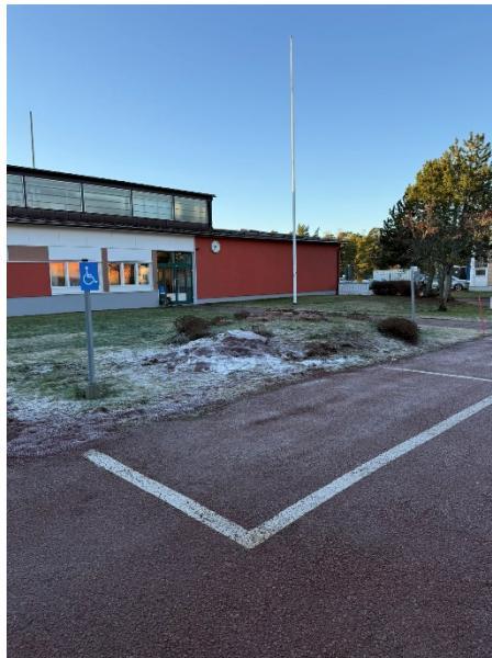
5. Entré till B-byggnaden.
